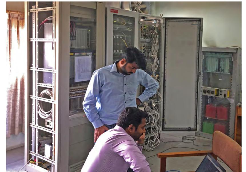
Im Punkt-zu-Punkt-Test zeigt sich, ob das SCADA-System korrekt arbeitet.
