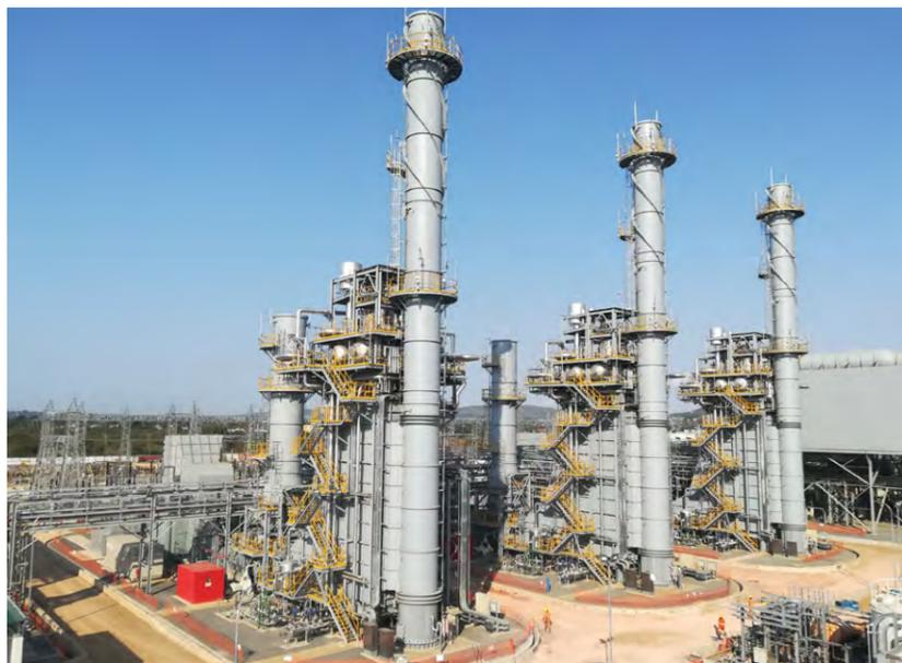
Eine der beiden Einheiten des neues Kraftwerks Kinyerezi II mit drei Gasturbinen und drei Abhitzeesseln
