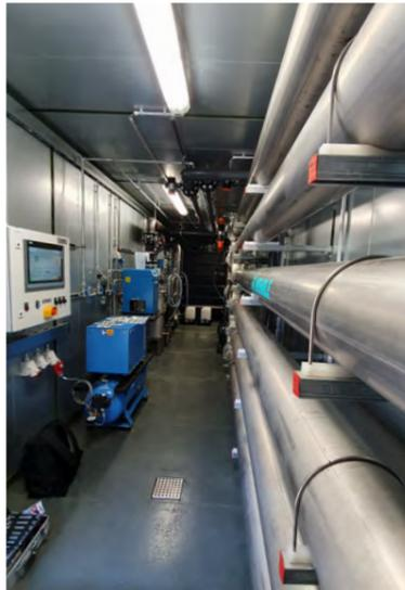
Eine neue Ultrafiltrationsanlage zur Prozesswasseraufbereitung verringert den Wasserverbrauch und die Abwassermenge der Malzfabrik.
